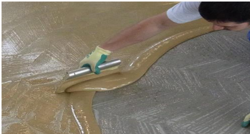
Figura 2: Aplicación del pegamento sobre la base
