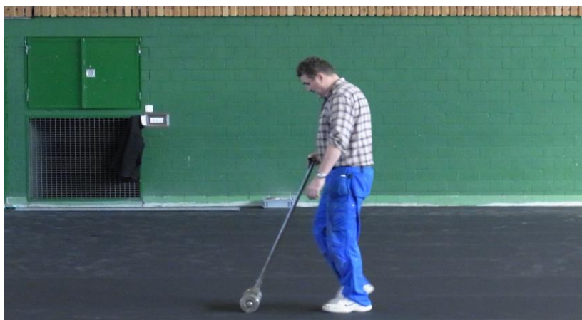
Figura 4: Apretar el recubrimiento elástico
