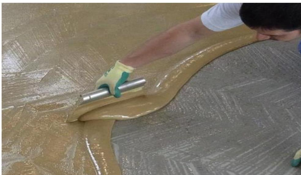
**Figura 1:** Aplicación de la cola sobre la base
