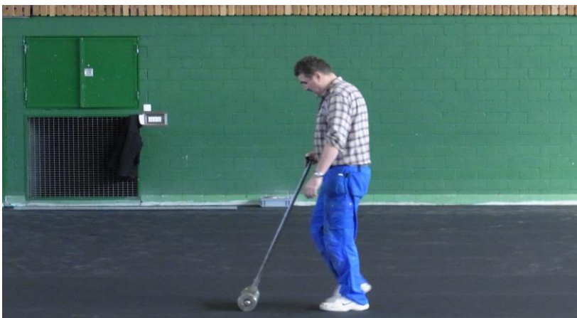
Figura 4: Apretar el recubrimiento elástico
