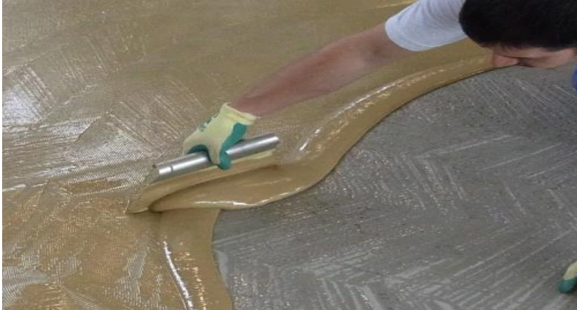
Figura 2: Aplicación del pegamento sobre la base
