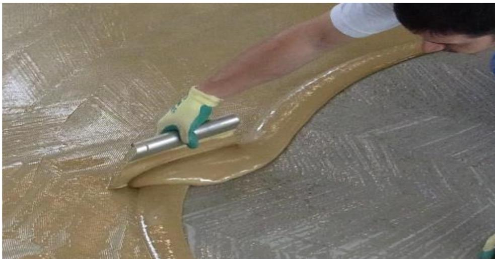
**Figura 1:** Aplicación de la cola sobre la base
