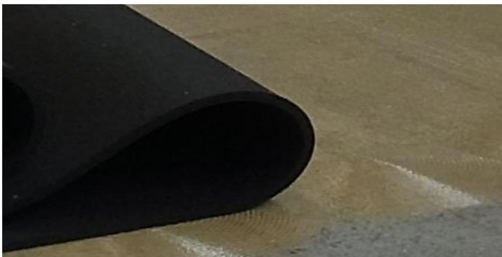
**Figura 2:** Desenrollar el revestimiento de suelo sobre el lecho de cola
