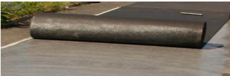
**Figura 2:** Desenrollar el recubrimiento elástico sobre el lecho de cola
