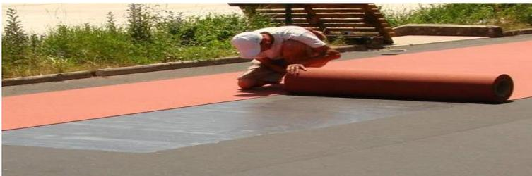
**Figura 4:** Desenrollar el revestimiento sobre el recubrimiento elástico
