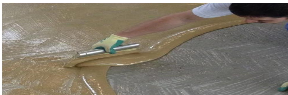
Figura 1: Aplicación del pegamento sobre la base
