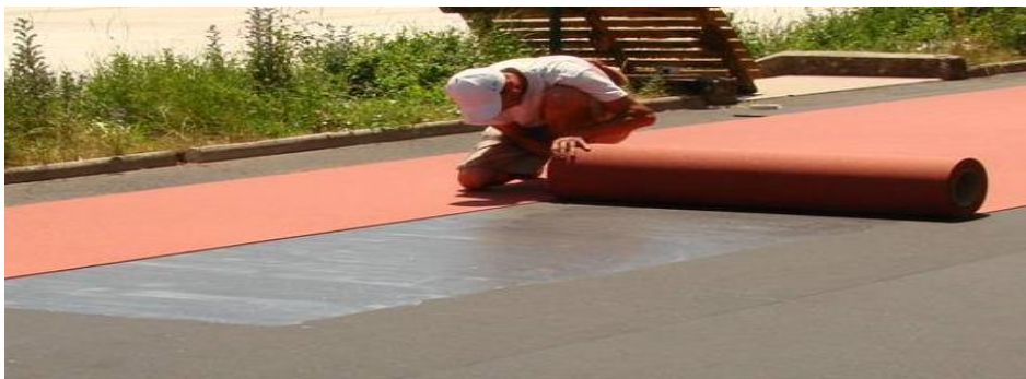
Figura 4: Desenrollar el revestimiento sobre el recubrimiento elástico
