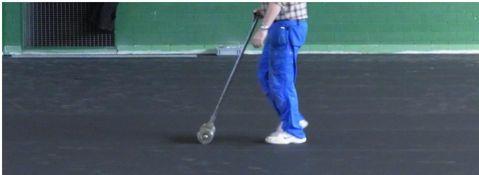
Figura 3: Apretar el recubrimiento elástico
