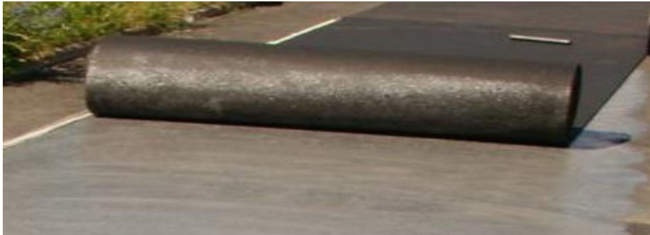
Figura 2: Desenrollar el recubrimiento elástico sobre el lecho de cola
