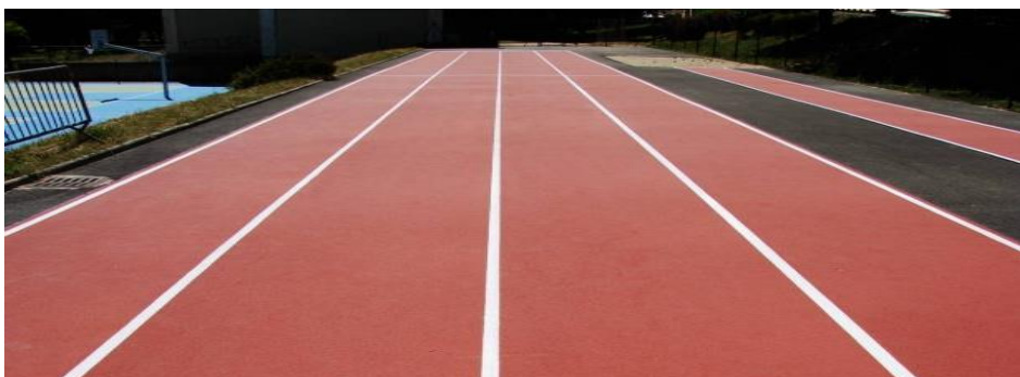
Figura 5: Aplicar las líneas sobre el suelo terminado
