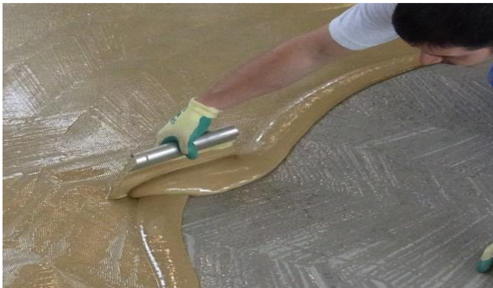
Figura 1: Aplicación de la cola sobre la base
